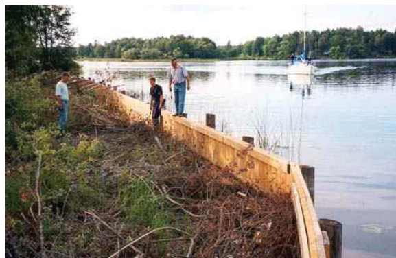
Efter knappt femton år hade plåtarna rostat av vid vattenytan och ersattes med en ny spontad sarg i trä. Till stora kostnader och frivilliga arbetsinsatser.
