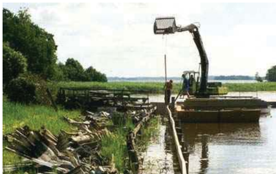
Efter knappt femton år hade plåtarna rostat av vid vattenytan och ersattes med en ny spontad sarg i trä. Till stora kostnader och frivilliga arbetsinsatser.
