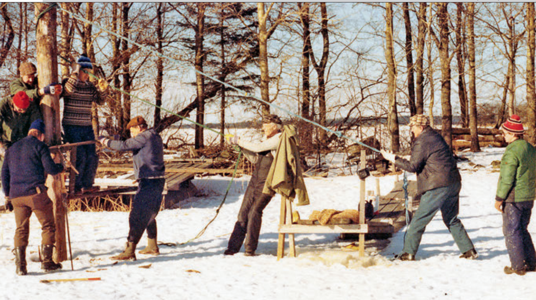
DET GICK ÅT mycket mankraft för att få pålar på plats för bryggor och skoning på Glipen vintern 1980.
