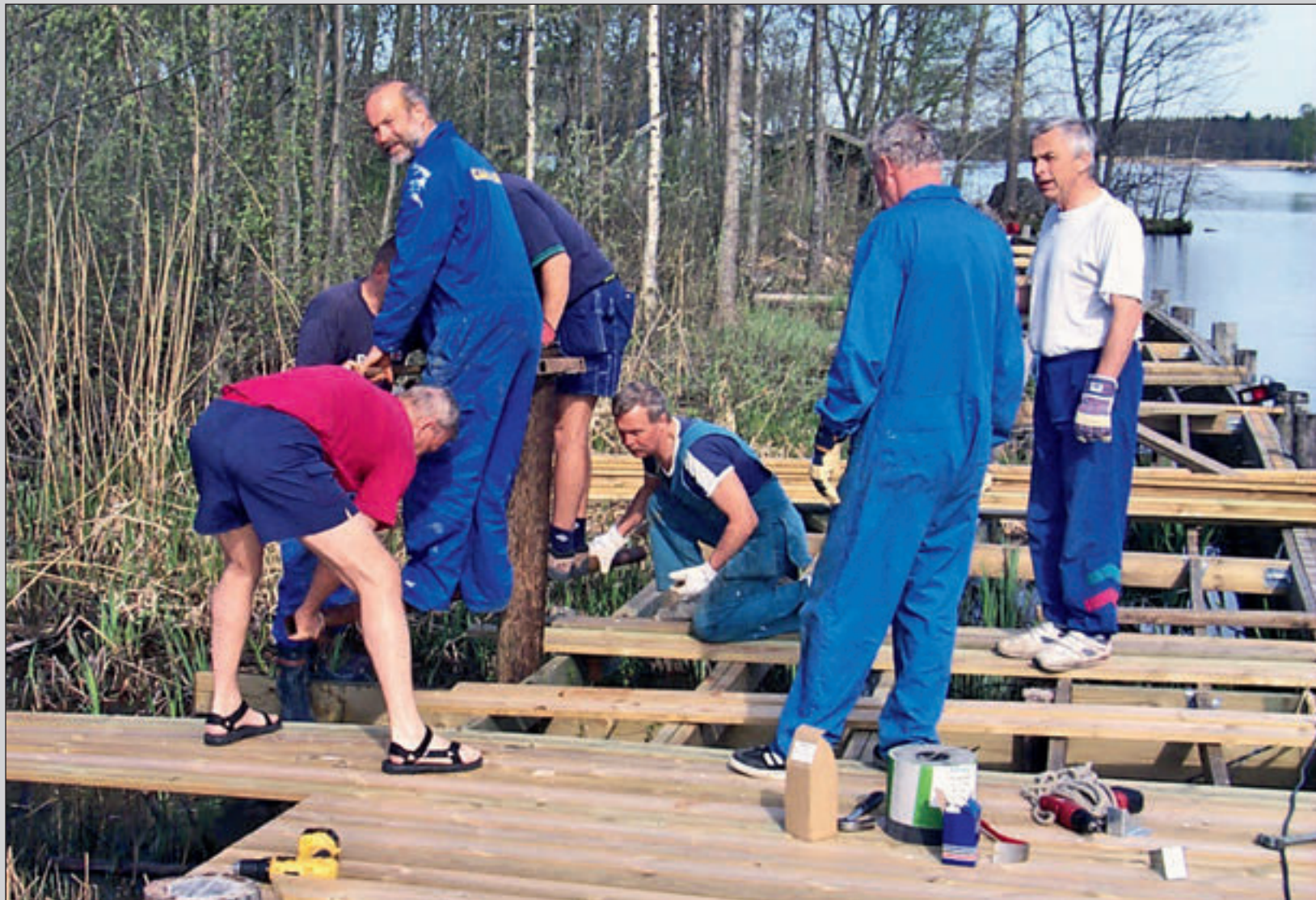
EFTER EN TID byggdes också gångbryggor utmed inloppet till hamnbassängen.
